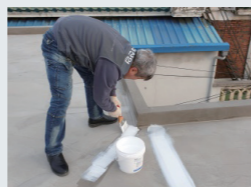
건조 후 투명해지면 2차 붓칠 시공
