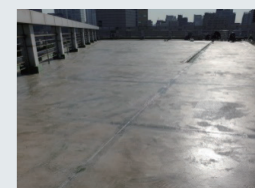
하도 시공 완료
