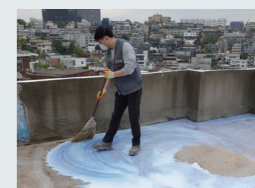
도포한 하도를 퍼트리듯 긴 빗자루로 1차 시공
