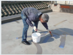
콘크리트 바탕의 경우 하도 시공
